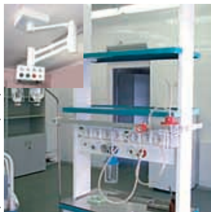
Консоль потолочная и консоль крепления «пол-потолок» (рис. 2)
